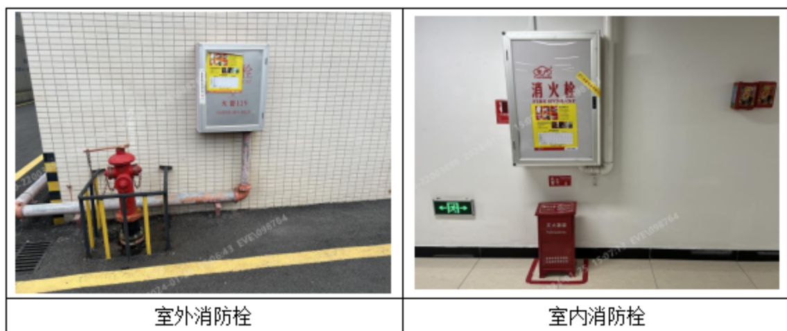
图 4.2-1 项目其他环保设施现场图片
