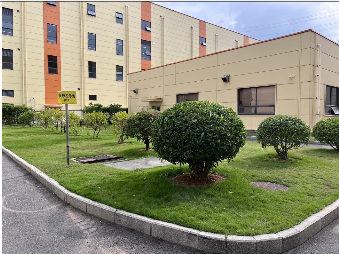
事故应急池（地下） 图 16 事故应急池现场照片
